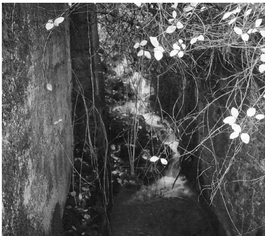
Der er stadig vandføring, hvor det 9,20 meter store vandhjul sad, i den dengang lukkede møllebygning.
