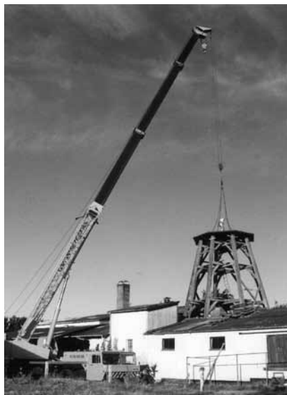
Nedtagningen af Niløse Mølle begyndt. Nedtagningen og flytningen til Als, udførtes af møllebygger John Jensen ApS. Foto: Per Gliese
