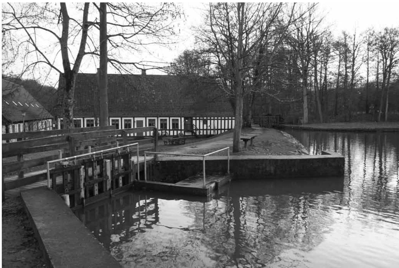
Ved Børkop Mølle har Vejle Kommune i 2008 lavet et nyt omløbsstryg, der erstatter den gamle fisketrappe. I projektet er der taget betydeligt hensyn til kulturmiljøet og vandmøllens bevaring. Foto: Morten Stenak
