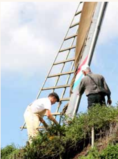
Der sættes sejl på møllen i Heeze af vores guide til venstre og Niels Christoffersen til højre. Vingerne er af typen "Van Bussel".
