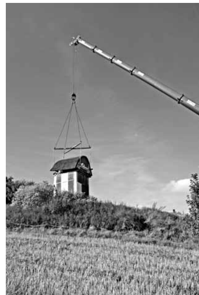
Først løftede man stråtaget af møllen, der var pakket ind og surret sammen, for ikke at skilles ad under flytningen.
