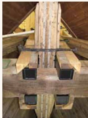
Stubben på møllen "Den Evert" ses her med forstærkning af fire jernpæle, beklædt med træ udenom.
