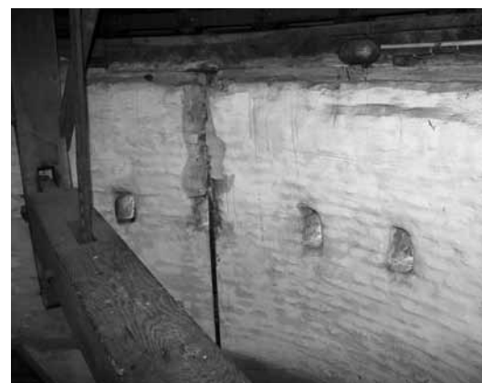
Her ses de firkantede huller under hatten, som bruges til stillads ved reparationer på hatten.
