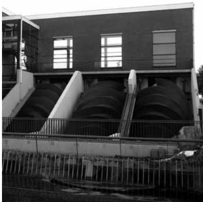
De tre archimedes snegle som har overtaget vindmøllernes funktion i dag.
