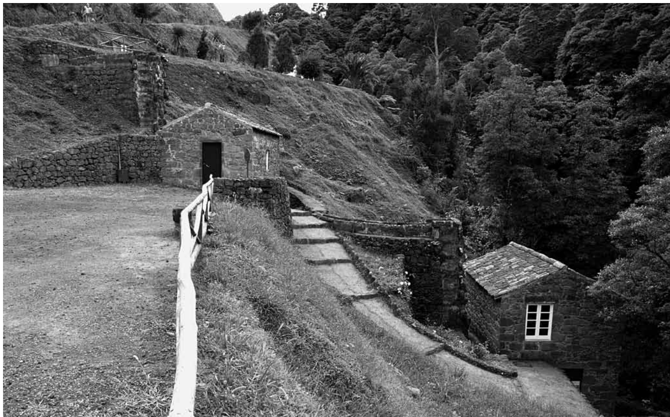
Vandmøllerne set nede fra den store tilkørselsplads, som man kan færdes ned til oppe fra vejen. Det fremgår tydeligt, hvorledes hele mølleanlægget med kanalerne er opbygget i de lokale stenressourcer. Foto, G. Solvang.
