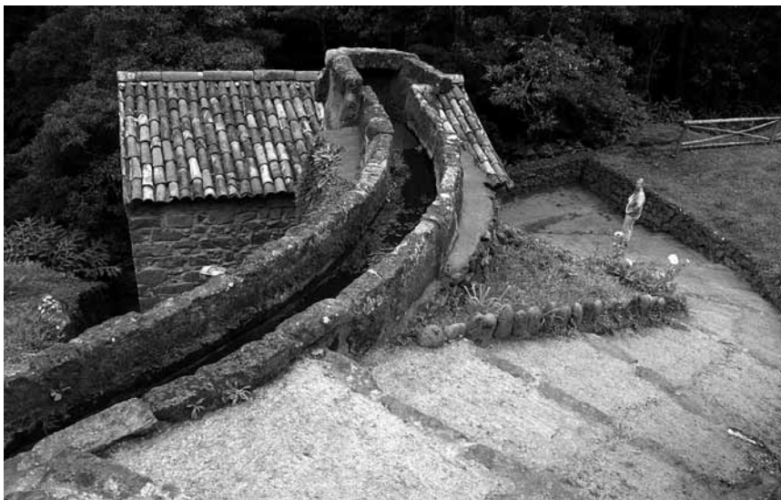
Ad den stensatte kanal løber vandet fra den øverste mølle ned til den høje vandskakt for enden af kanalen, hvorefter det ledes ud underneden og i en stråle ind på vandhjulets skovlblade. For at få det færdigmalede mel transporteret op til pladsen ovenfor, har det været nødvendigt at bære det op ad den brede stentrappe. Foto, G. Solvang.
