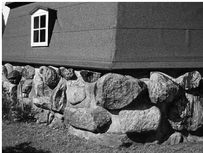
Kampestensfundamentet, der måske var årsag til at møllen blev skilt ad. Foto: Jens Erik Christiansen
