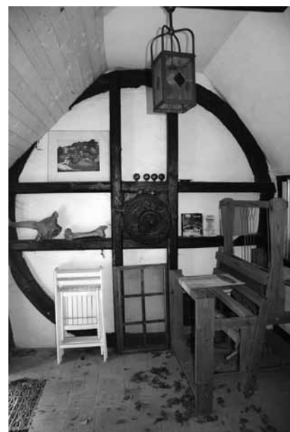
Sjov detalje i Kerris Mølle. Den ene ring fra det gamle vandhjul samt akslen, muret ind i væggen.
