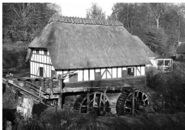
Vejstrup Mølle på Sydfyn, som har fået udvidet sin fredning, til at omfatte de to vandhjul, stemmeværk m.m.
