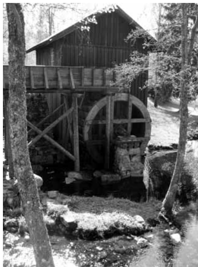
Vandhjulet på Sandbekk Mølle har en diameter på 430 cm. Foto: Bodil Kjærgaard.
